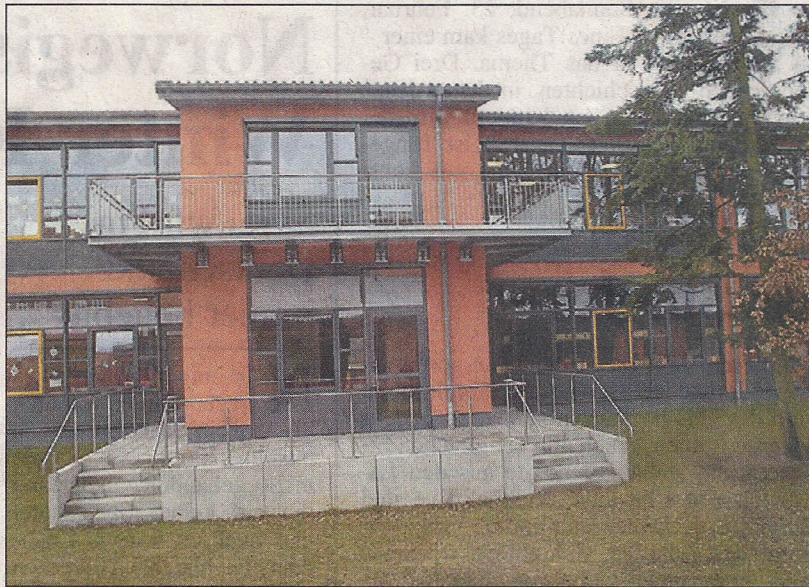
DER NEUE KLASSENTRAKT der Grundschule Süd.
